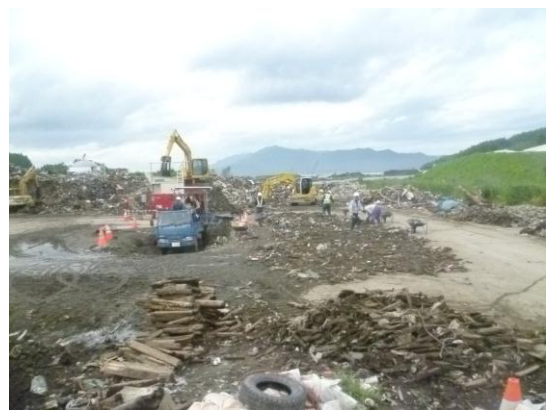
重機及び人力による粗選別（仮置場内）
