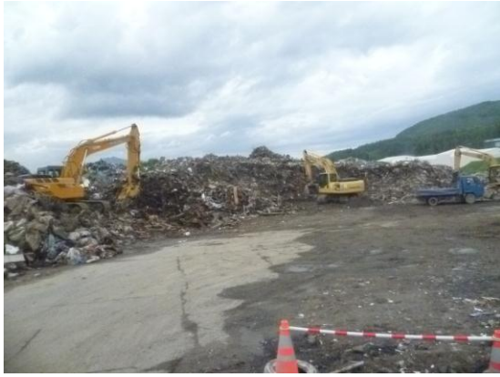
災害廃棄物仮置場の状況
