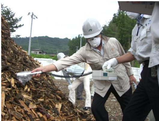
木質系可燃物の選別状況確認及び放射線量測定
